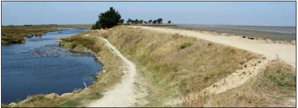
Figure B.1.5 : La digue du polder de Sébastopol (Noirmoutier)
