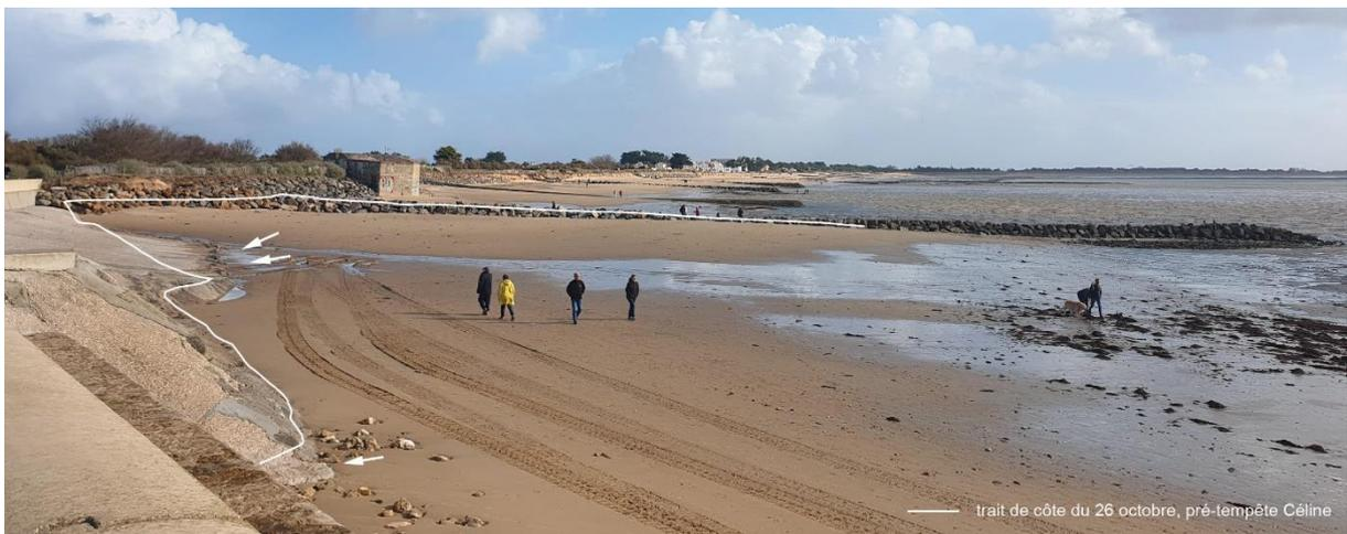
**Situation post-tempête Céline, le 29 octobre à 11h15.** La tempête a provoqué le démaigrissement le plus important depuis l'instrumentation du site avec le système Coastsnap, atteignant approximativement entre 0,5 et 1 m en haut de plage au niveau de l'enrochement (second plan à gauche). La base du perré a été affouillée (flèches). L'ouvrage a été partiellement détruit à proximité de la station Coastsnap (non visible ici).
